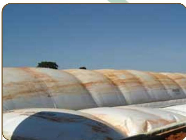
Figura 7: Biodigestor em lona de PVC.
