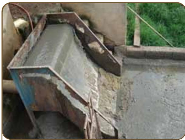
Figura 5: Separação prévia de sólidos para entrada no biodigestor.
