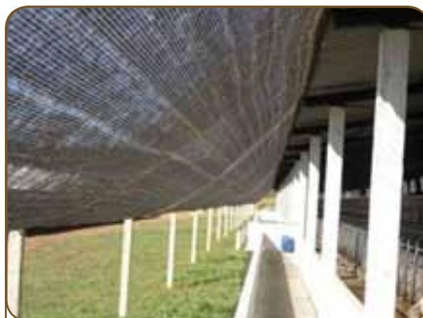
Figura 12: Sombrite para reduzir a incidência de sol no interior das instalações.
