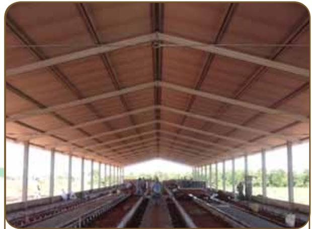
Figura 8: Telhas térmicas (poliestireno).
