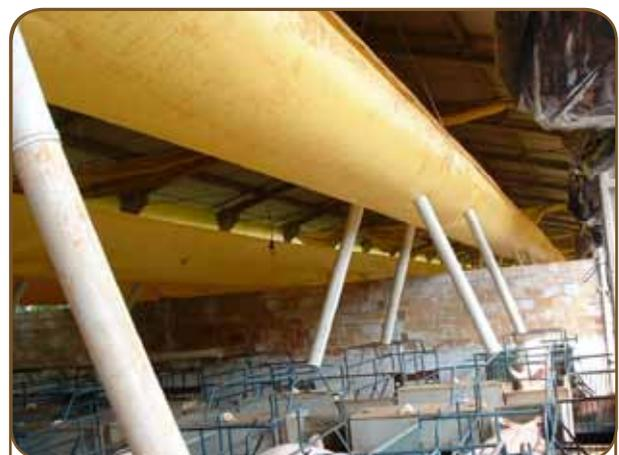
Figura 4: Resfriamento axial - ar refrigerado sobre a cabeça da matriz.
