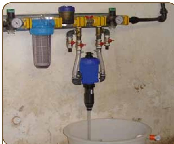
Figura 19: Sistema dosador para medicação via água.
